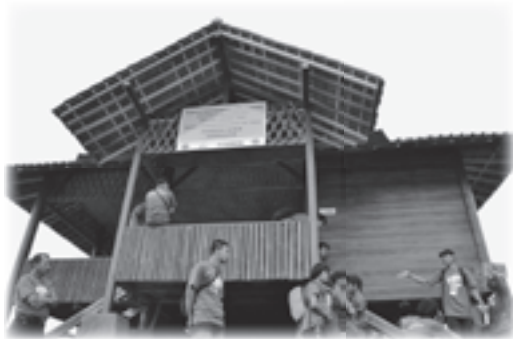
パトロール用の監視小屋も建設
